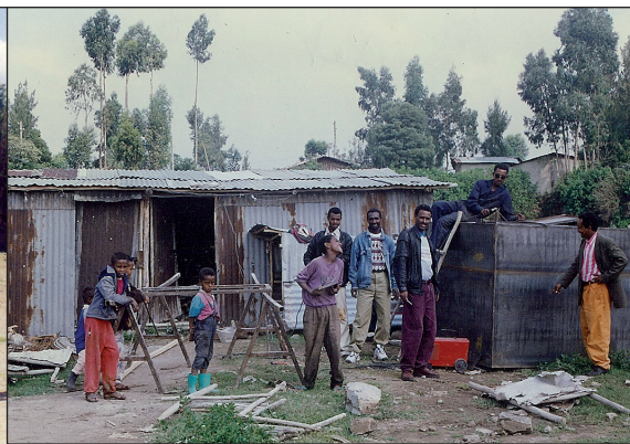
La démolition de l'école (1998)
