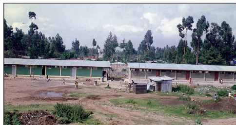
L'école en construction avec ses nouveaux bâtiments (1997)
