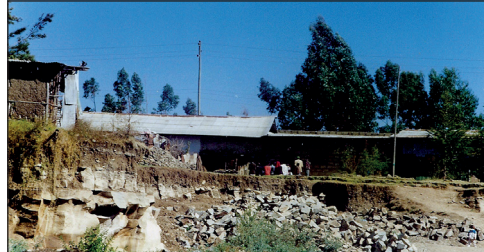
L'école avant les travaux
